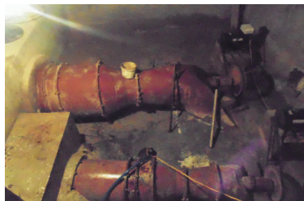
Tổ máy điện thủy triều công suất 5 kW
